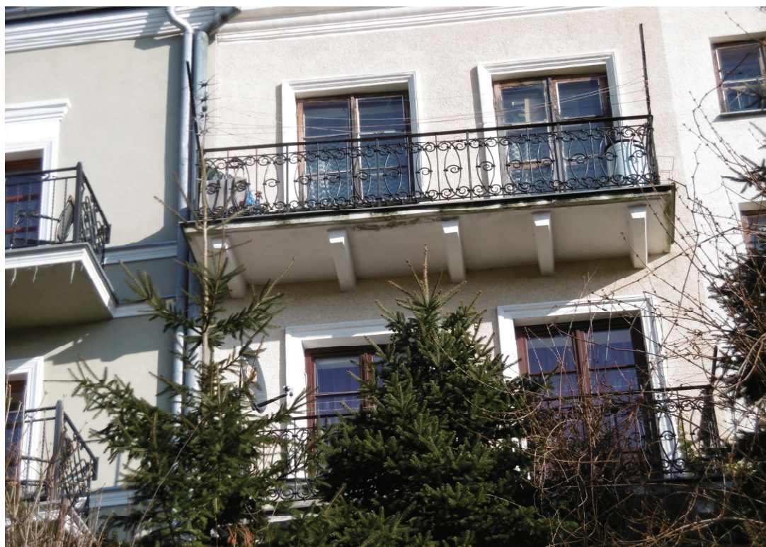
Fot. Nr 3 Elewacja zachodnia - uszkodzony tynk na balkonach
